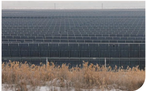
项目地: 中国·新疆石河子 容量: 94MW 解决方案: 天智2跟踪系统
